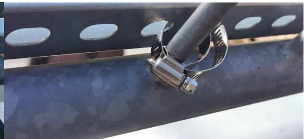
Abbildung 4: Montage der Edelstahl Rohrschellen
