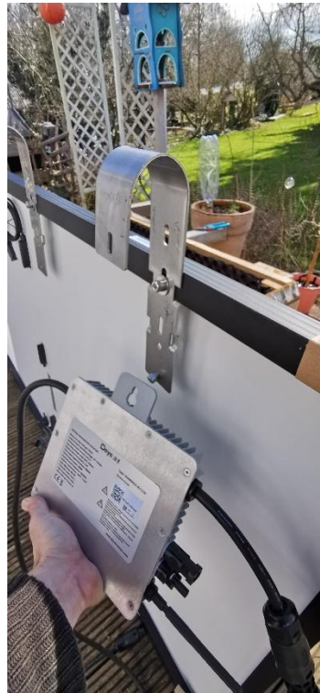
Abbildung 11: Einhängen des Wechselrichters und Anziehen der M8 Schraube
