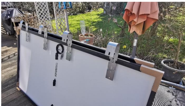
Abbildung 8: Installierte Geländerhaken
