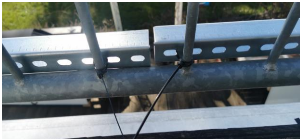
Abbildung 3: Fixierung der Montageschienen am unteren Ende des Geländers mit Kabelbinder
