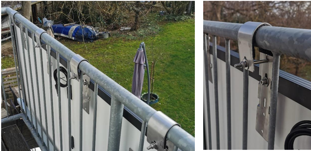
Abbildung 13: Installierte Geländerhaken mit untergeschobenen Gummigranulatplatten
