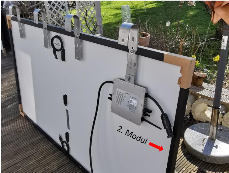
Abbildung 9: Der Wechselrichter muss immer auf der Seite des Nachbarmoduls befestigt werden
