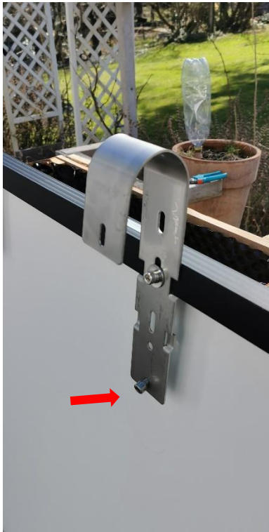
Abbildung 10: Ansetzen einer M8 Schraube
