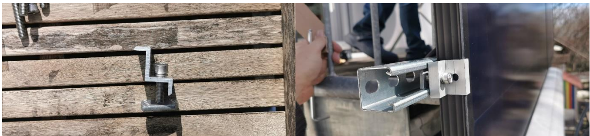
Abbildung 16: Die Schraube wird in den kurzen Schenkel der Montageklemme angebracht
