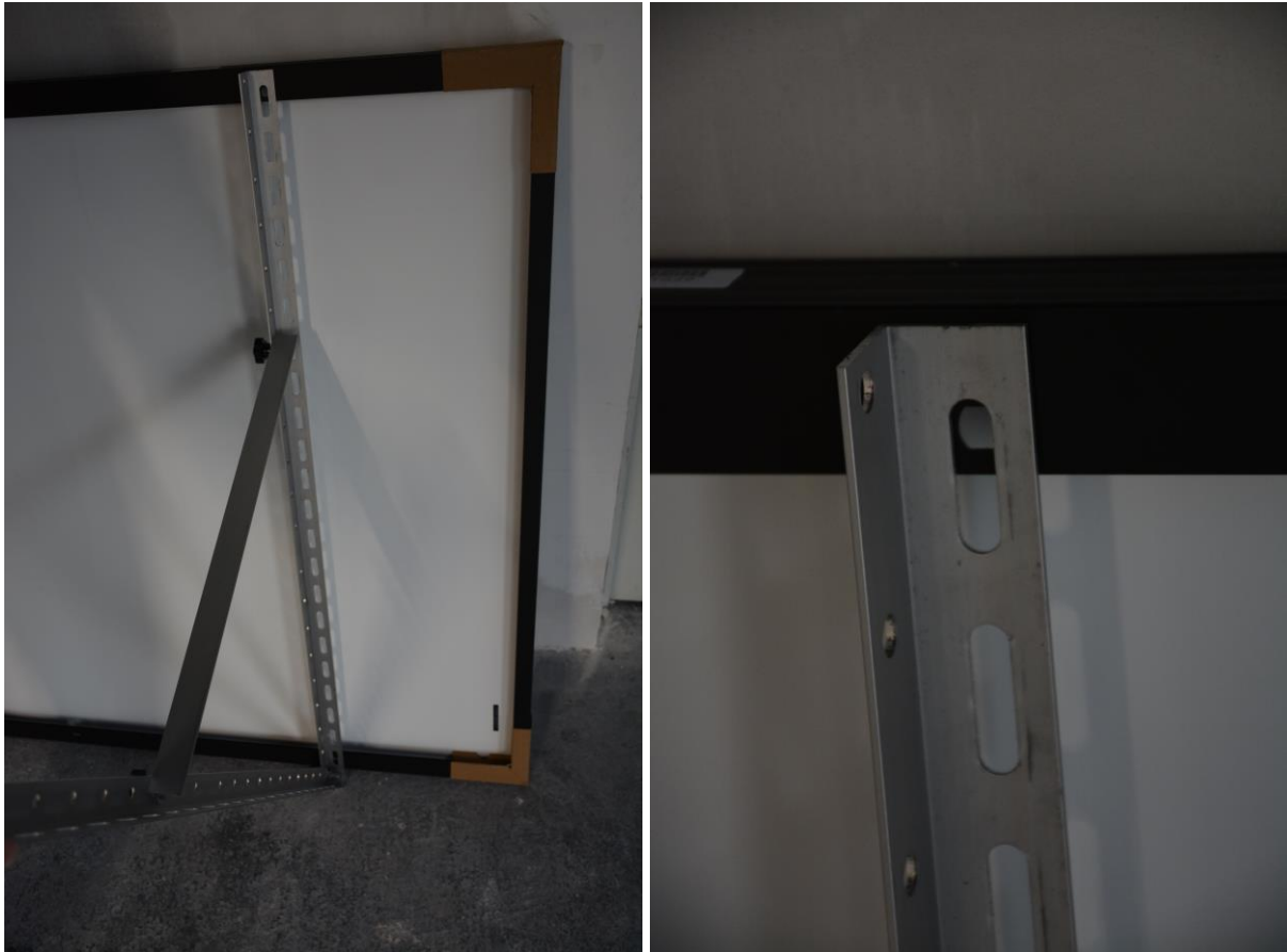
Abbildung 12: Das letzte Loch der Aluschienen trifft genau die Installationslöcher des PV-Moduls
