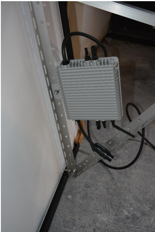
Abbildung 15: Montage des Wechselrichters mittels einer M8 Schraube
